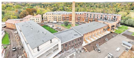
In die historischen Bauteile konnten bereits die ersten Mieter einziehen.
