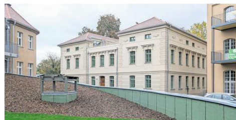
Die Fabrikantenvilla ist das Herzstück der Papierfabrik und wurde aufwendig rekonstruiert.
